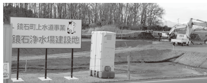
浄水場整地工事
